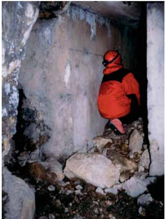
*Foto 5 - Tratto di galleria rinforzato in cemento nel sistema di gallerie del Majo, non ancora rilevato e non risultante dalle topografie d'epoca. (Disegno n° 1).*
